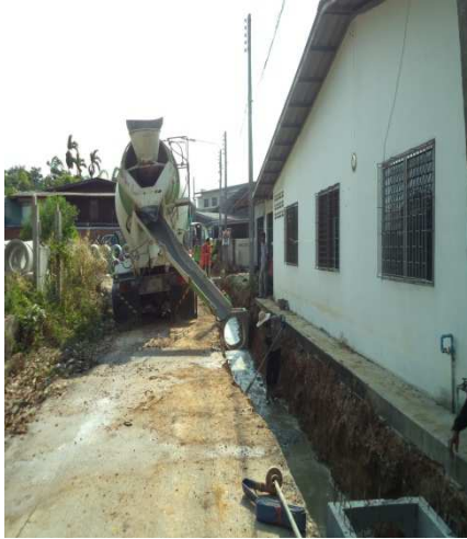
๗. โครงการวางท่อระบายน้ำพร้อมบ่อพักรางวี คสล.ซอยบ้านนางโม้ยผ่านจินดาวัฒน์เชื่อมถนนพลงช้างเผือก (ชุมชนหนองกระโดง)
