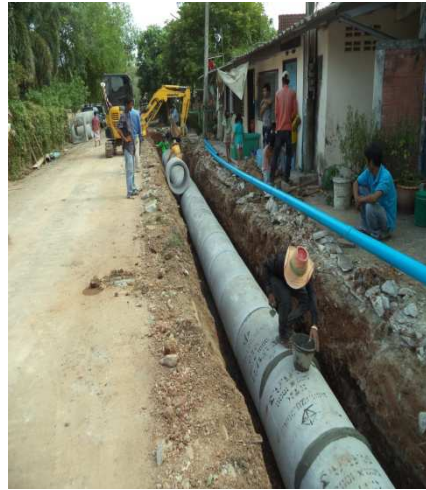
๘. โครงการวางท่อระบายน้ำพร้อมบ่อพักรางวี คสล.ถนนซอยรุ่งนภา (ชุมชนแกลงแกลัวกล้า)
